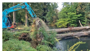
Enlèvement d'embâcles à Pont Saint Pierre
